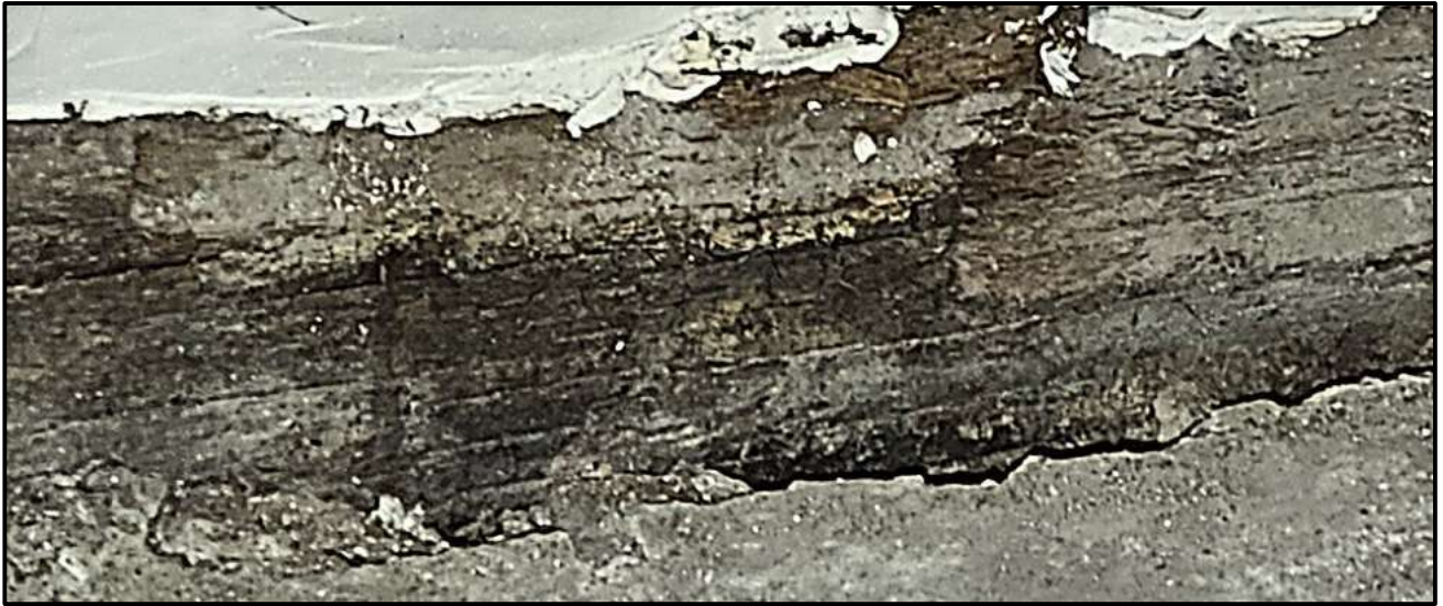
Pourriture cubique sur la façade Est de sablière sur sa partie Nord
