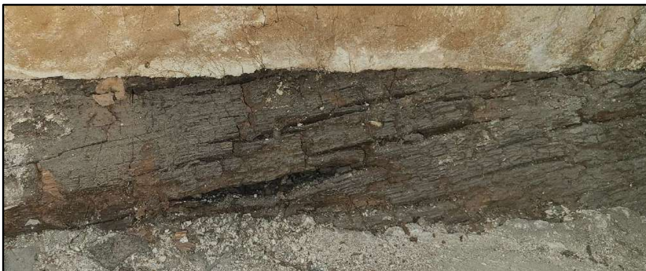
Pourriture cubique sur la face supérieure de la sablière au sud de la passerelle
